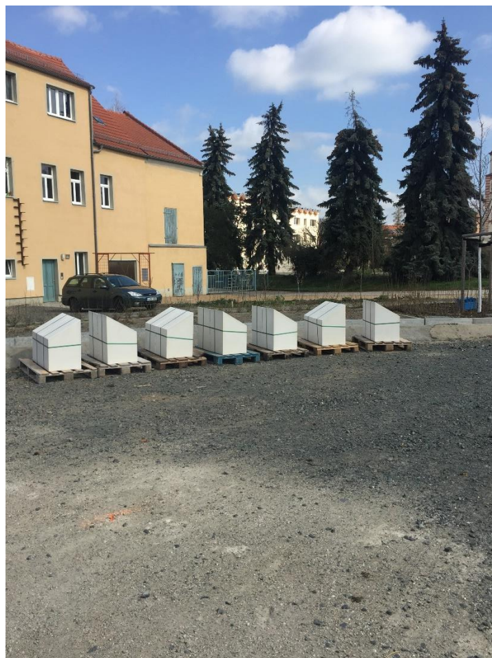
Abb. 1: 14 Betonkuben á 250 kg warten auf ihre Aufstellung
