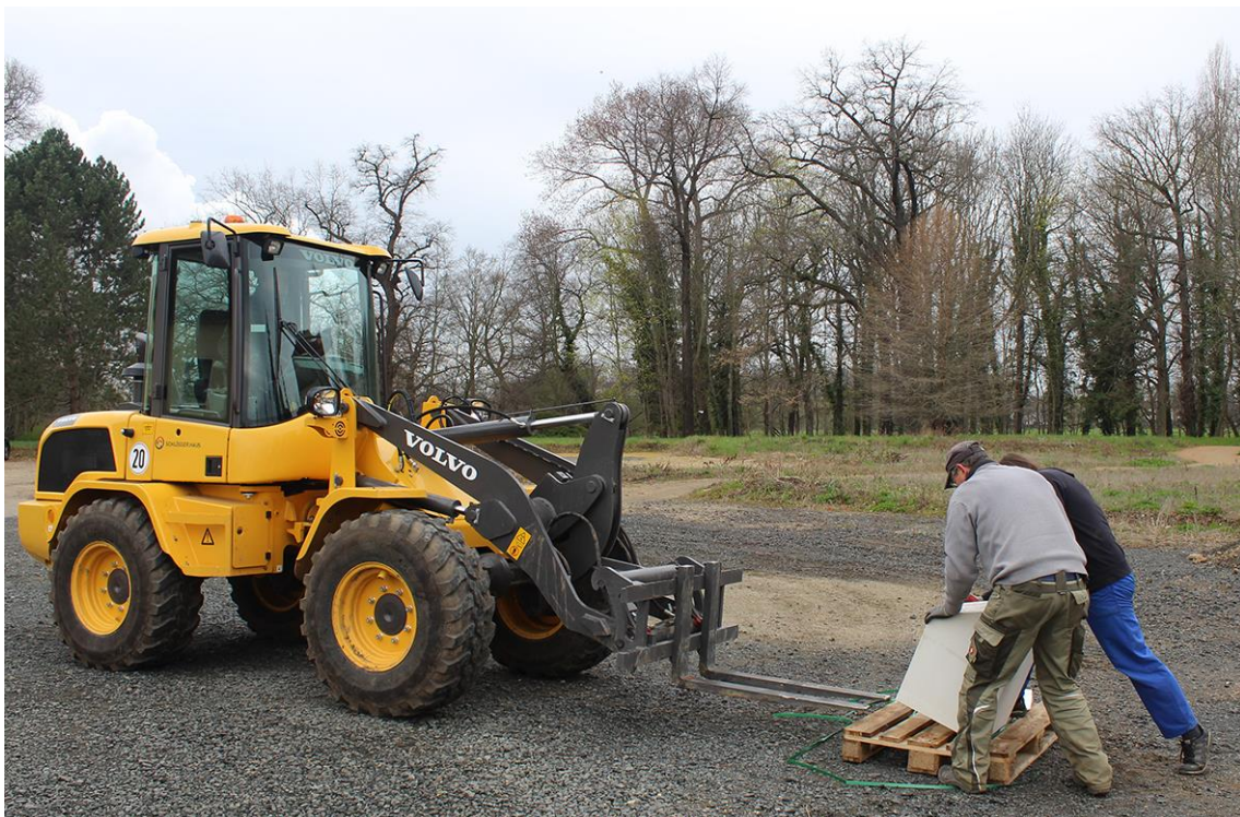
Abb. 3: Dank Vorsicht und Geschicklichkeit gelang der Einbau ohne Schäden
