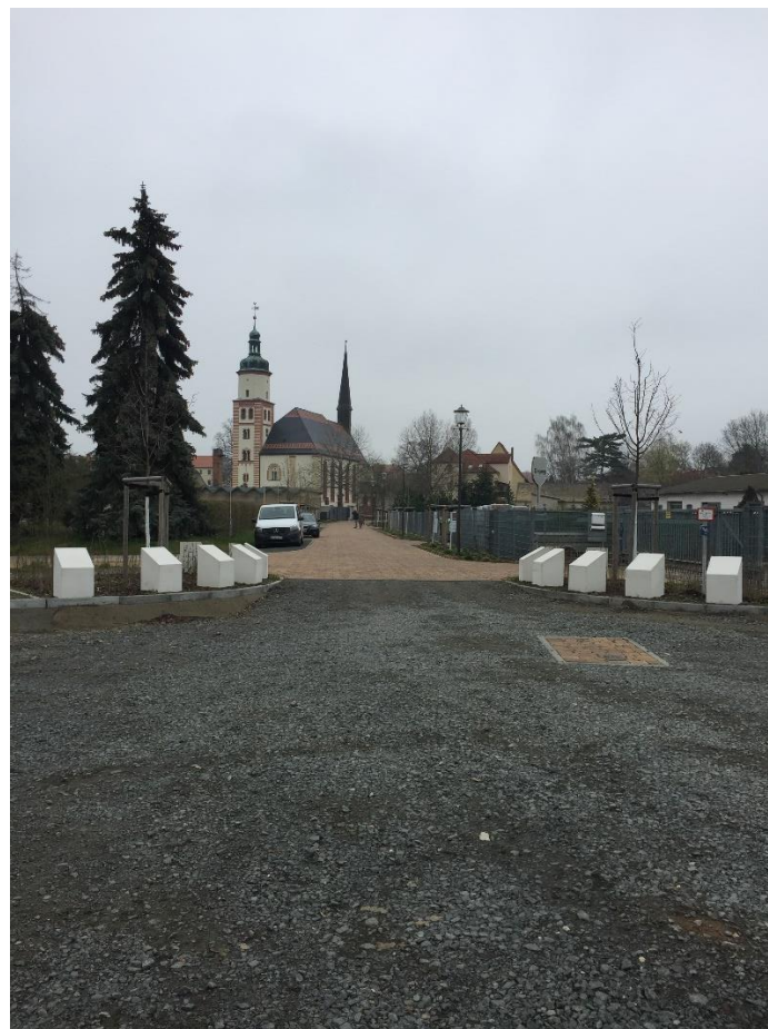
Abb. 5: Die fertige Anordnung der Betonkuben
