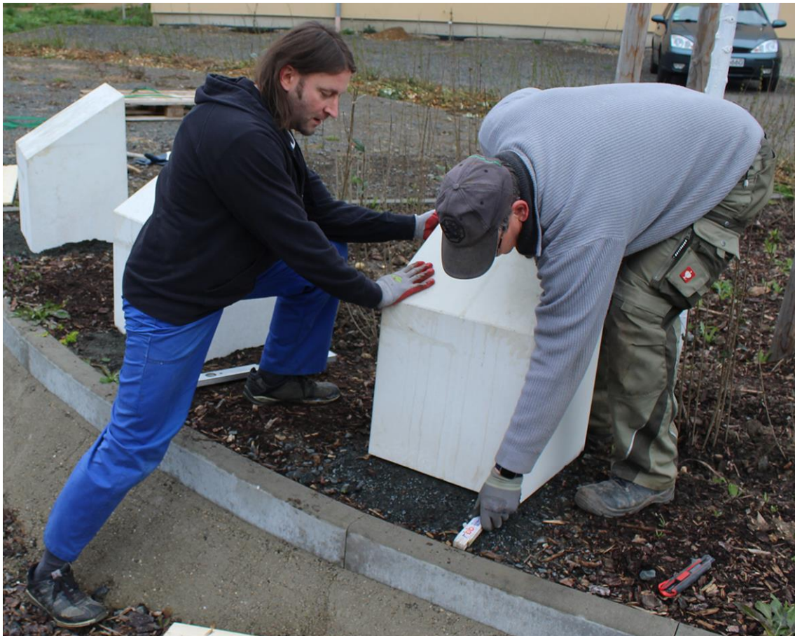
Abb. 2: Danilo Ober (l.) und Andreas Lenk (r.) bei Einbau der Betonkuben
