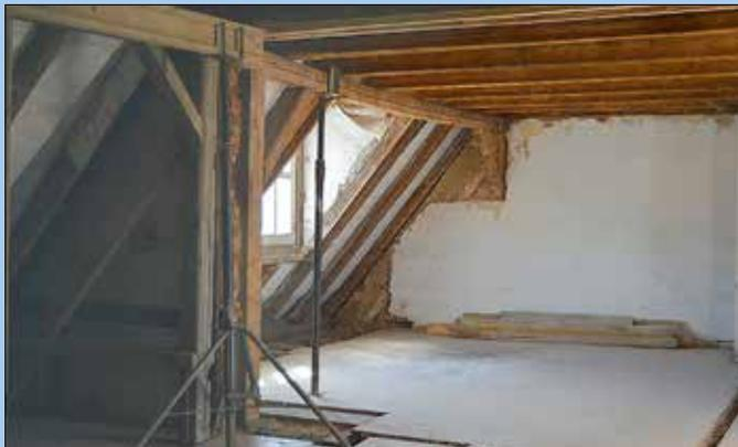
Die **Restaurierungsmaßnahmen** im **Altbau** des Rathauses schreiten ebenfalls mit großen Schritten voran. Die Entkernungsarbeiten sind beendet. Aktuell finden noch Arbeiten an den Rohrinstallationen im Bereich Heizung/ Sanitär und Elektro statt. Zukünftig wird es noch Holzschutzarbeiten geben und die Unterspannbahn muss in einem begrenzten Bereich repariert bzw. erneuert werden. Dazu werden Dachdeckerarbeiten von Nöten sein.
